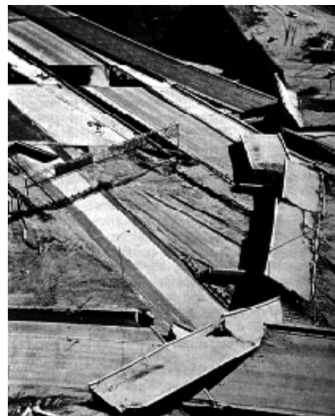
Zerstörung eines Autobahnknotens durch ein Erdbeben in Kalifornien
